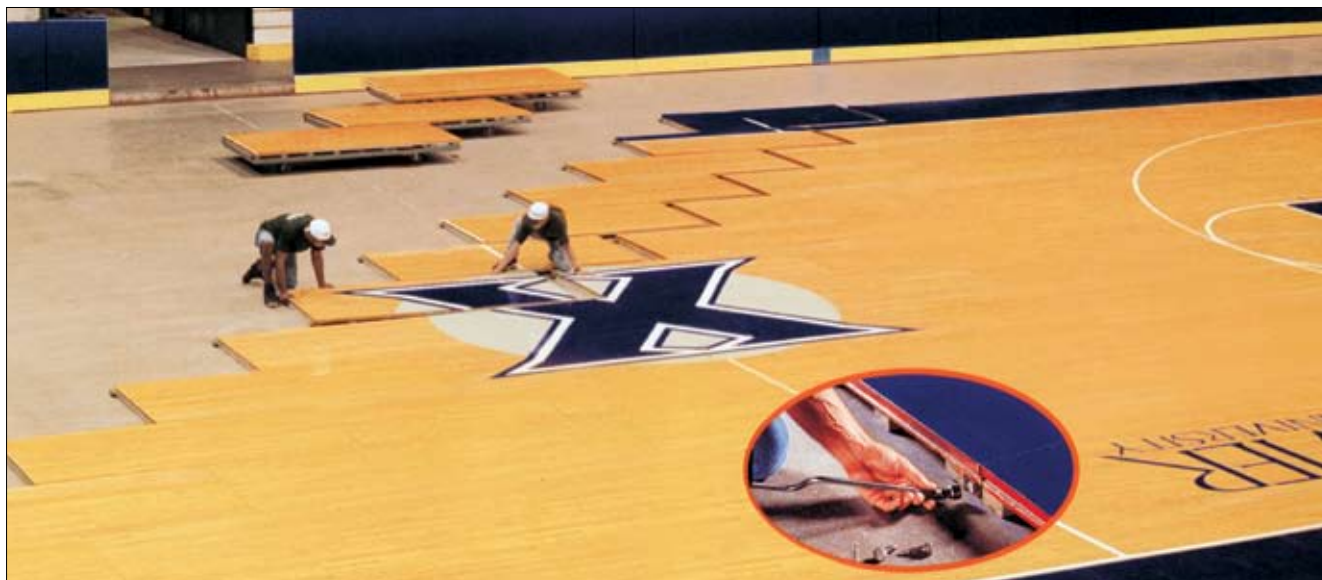
Montaż drewnianej podłogi składanej All-Star firmy Robbins
