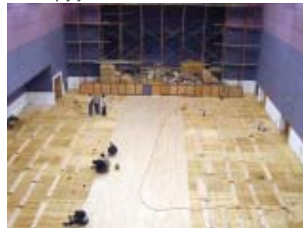
Klepka – montaż z góry.
