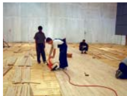
Klepka – montaż.
